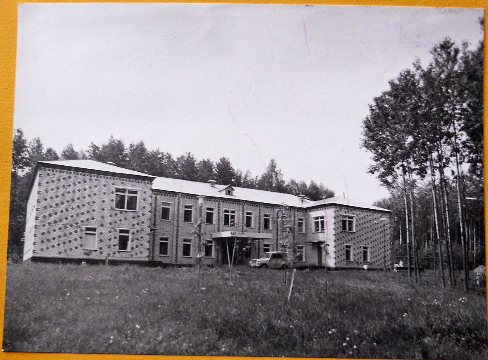
Поликлиника №2 МСЧ-94 сдана в эксплуатацию 25.01.75 года. Построена по типовому проекту 2-05-623/61. Мощность поли- клиники 250 посещений в смену. Район обслуживания пос. Рем- маш и д. Иудино включает в себя участки: терапевтических - 3, педиатрических - 3, стоматологических - 2.
